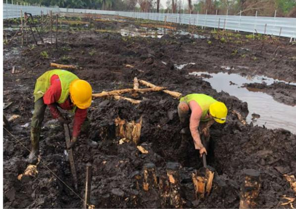
Gambar 3. Proses Pekerjaan Kayu Gelam KLHK
