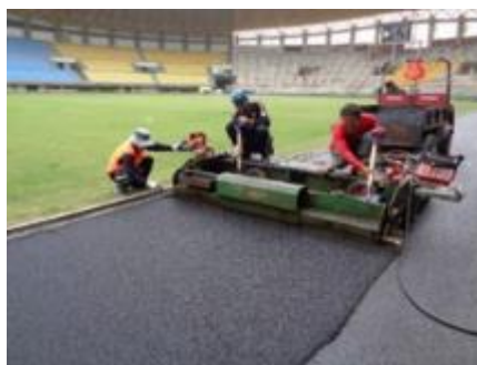
Gambar 3. Pekerjaan Base Layer
