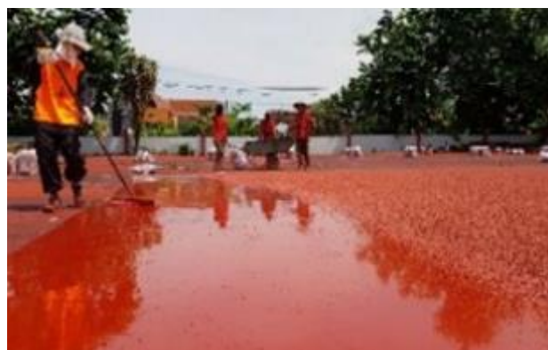
Gambar 4. Pekerjaan Seal dan Top Layer
