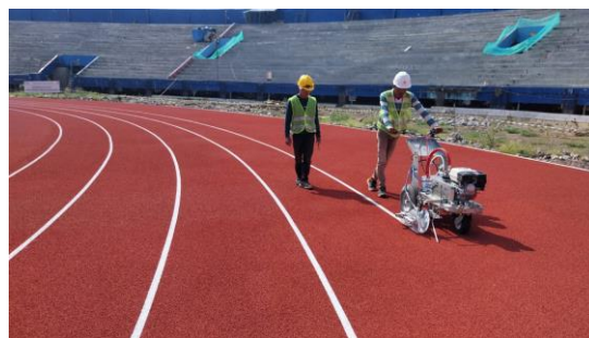
Gambar 3. Pekerjaan Line Marking
