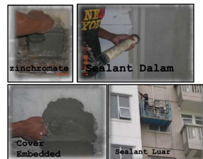
Gambar 12. Finishing dan Sealant
