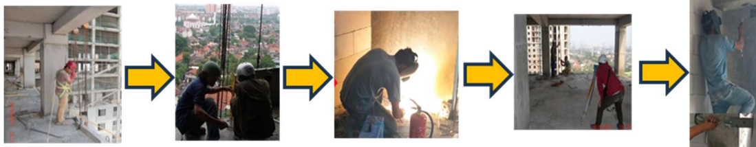
Gambar 11. Pemasangan Precast Erection
