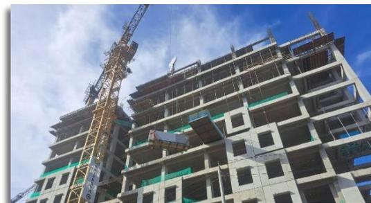
**Gambar 6.** Lifting panel prefab dengan menggunakan Tower Crane
