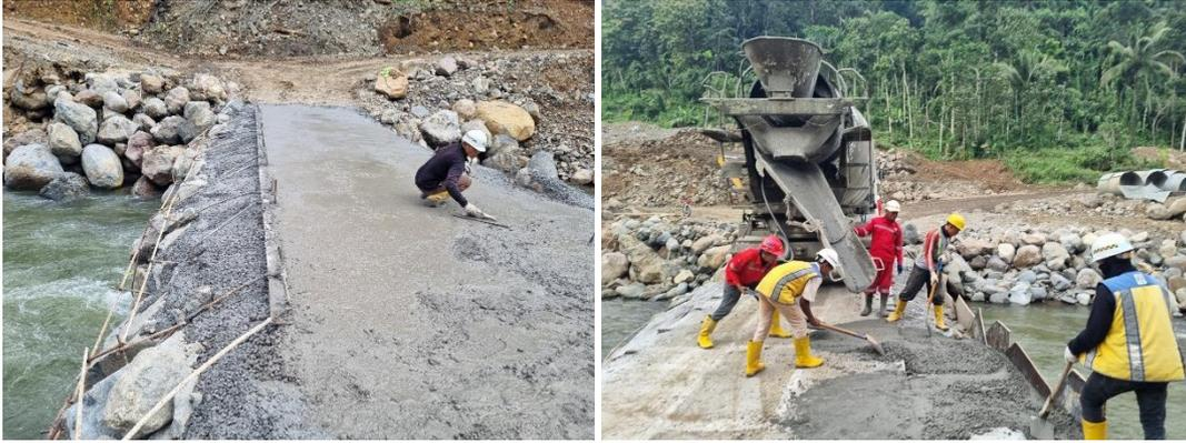
Gambar 11 Proses Pengecoran
