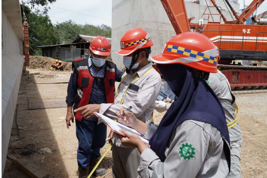
Gambar 5. Pengecekan Alat dan Kondisi Girder
