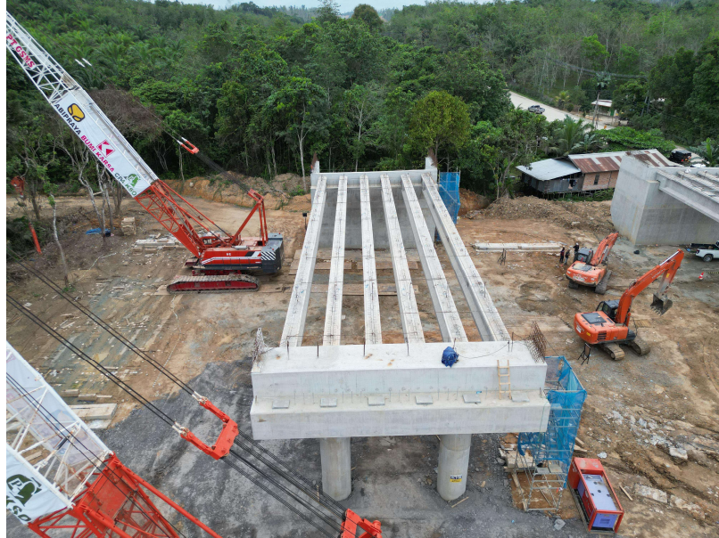
Gambar 9. Proses Pemasangan Bracing Sementara
