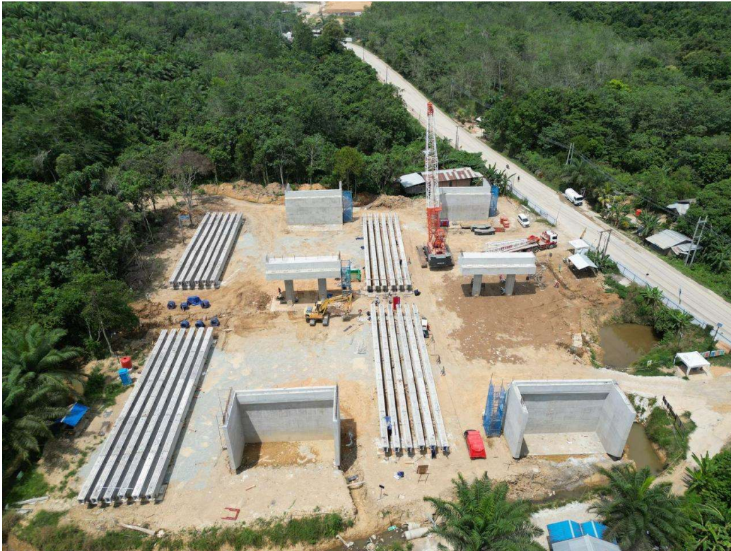
Gambar 2. Lokasi Pekejaan Jembatan 5 Proyek Pembangunan Jalan Bebas Hambatan Seksi 6B (IKN)
