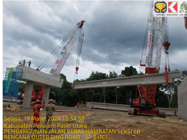
Gambar 7. Proses Pengangkatan Girder
