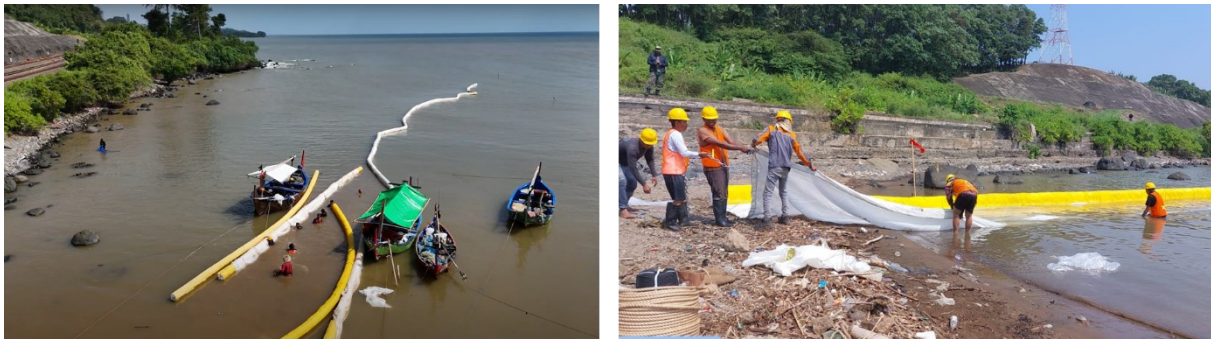
Gambar 8. Pekerjaan Silt curtain Pekerjaan Pembangunan Terminal Multipurpose Batang Tahap I
