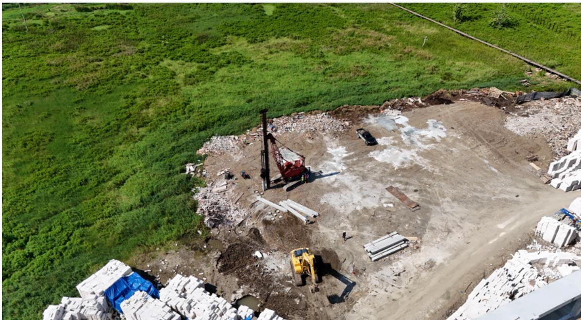
**Gambar 4.1** Pekerjaan Pemancangan Tiang Pancang 40x40 Struktur Gedung Parkir
