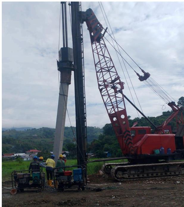
**Gambar 1.1** Pekerjaan Pemasangan Tiang Pancang 40x40 Struktur Gedung Parkir
