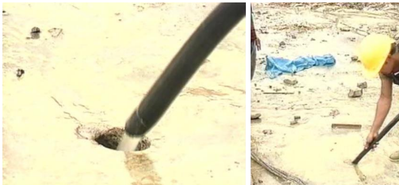
Gambar 12. Gambar Pelaksanaan Pembersihan Lubang Grouting .
