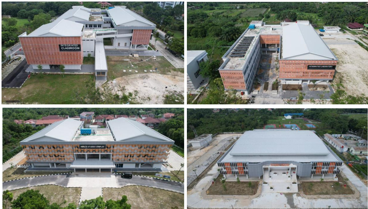
Gambar 1. Dokumentasi 4 Gedung CWR-01 UNRI
