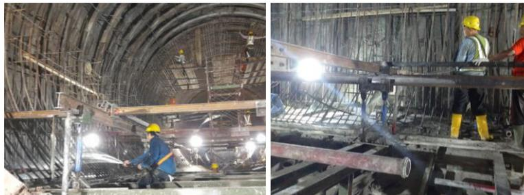
*Gambar 4.10 Perawatan Beton (Curing) pada Beton K-300 Lower Bangunan Pelimpah (Spillway)*
