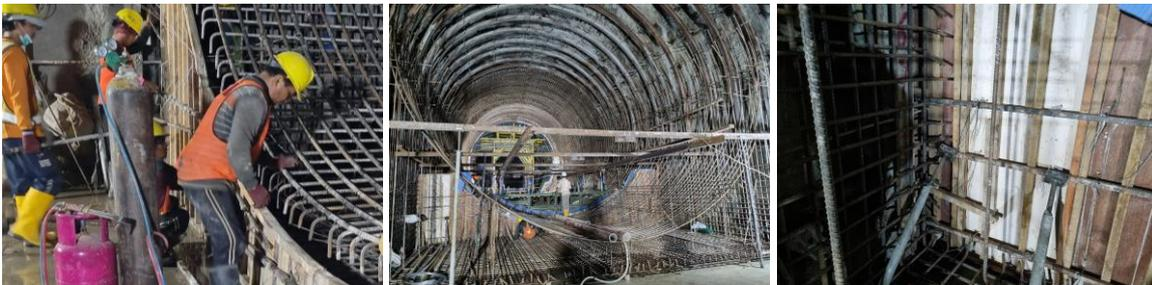
Gambar 4.8 Pekerjaan Pemasangan Bekisting Non Expose (Konvensional) pada Lower Bangunan Pelimpah (Spillway)
