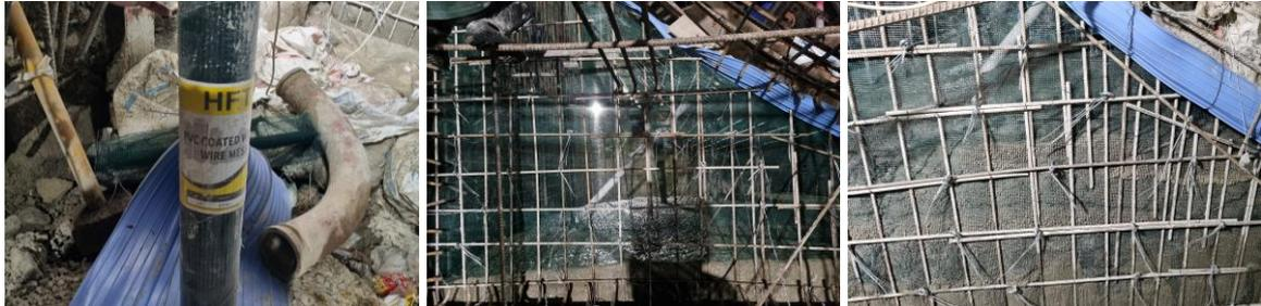
Gambar 5.1 Penggunaan *Chicken net* sebagai Material Alternatif untuk Pekerjaan Bekisting Non-expose pada Lower Terowong Bangunan Pelimpah (Spillway)
