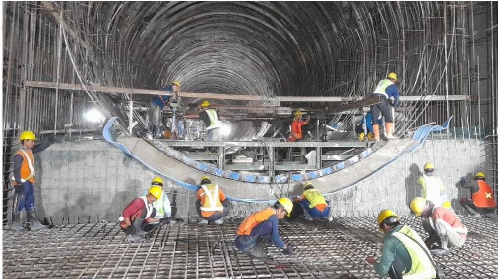
*Gambar 4.4 Pekerjaan Terowong Bangunan Pelimpah (Spillway)*
