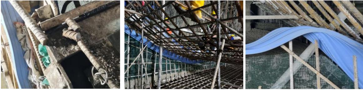
Gambar 4.7 Pekerjaan Pemasangan PVC Waterstop pada Lower Bangunan Pelimpah (Spillway)
