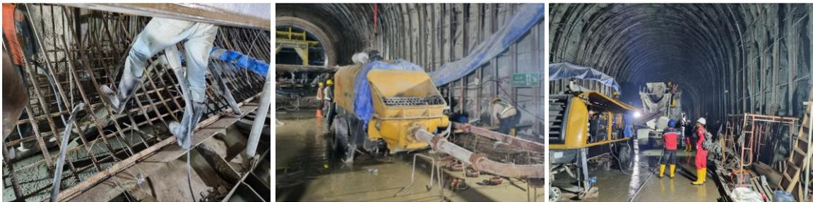
Gambar 4.9 Pekerjaan Pemasangan Pengecoran Beton K-300 pada Lower Bangunan Pelimpah (Spillway)
