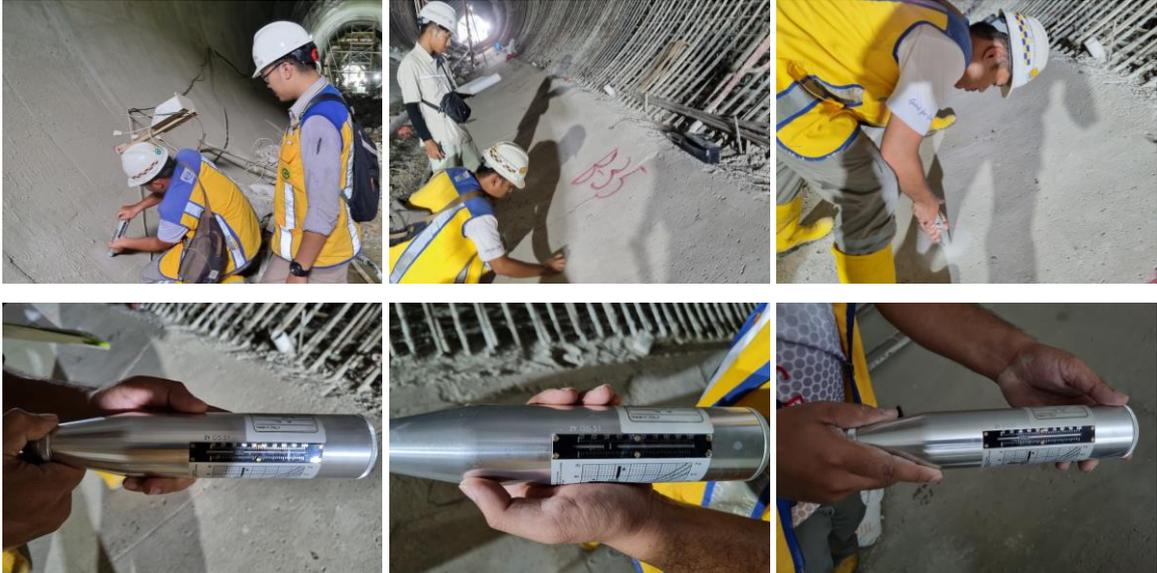
Gambar 5.2 Pengujian Mutu Beton K-300 pada Lower Terowong Bangunan Pelimpah (Spillway)
