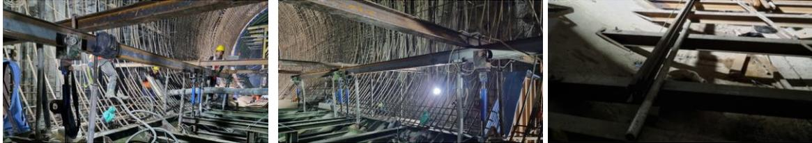
Gambar 4.6 Sliding Form pada Pekerjaan Bekisting Expose untuk Lower Bangunan Pelimpah (Spillway)
