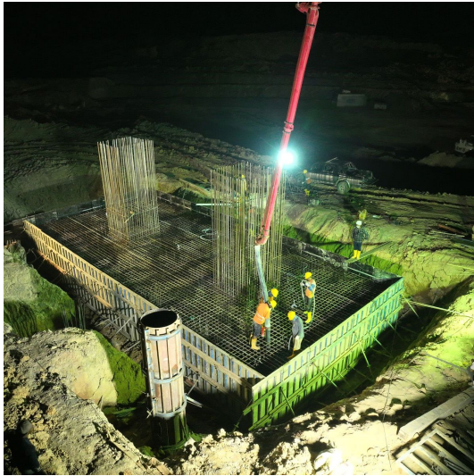
Gambar 7 Proses Pengecoran Pile Cap Jembatan Sungai Wain
