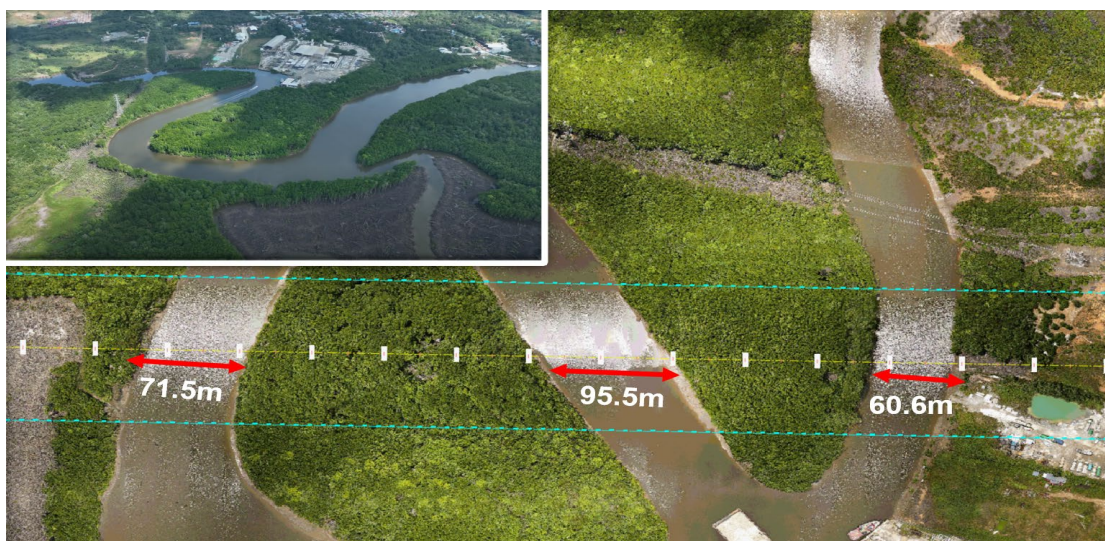
Gambar 1 Lokasi Jembatan Sungai Wain pada Jalan Tol IKN Seksi 3A
