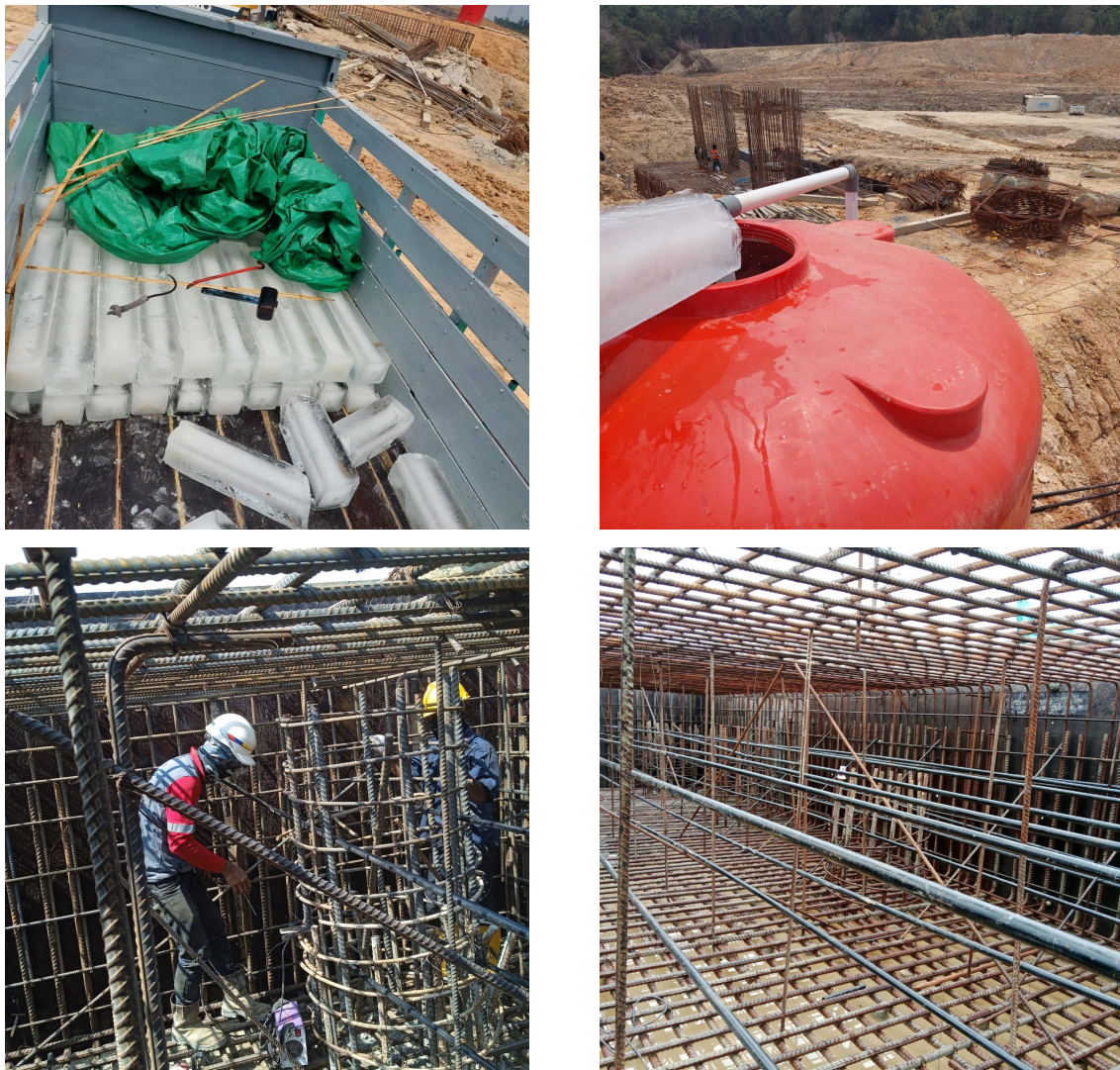
Gambar 6 Pemasangan Pipa pada Pile Cap Jembatan
