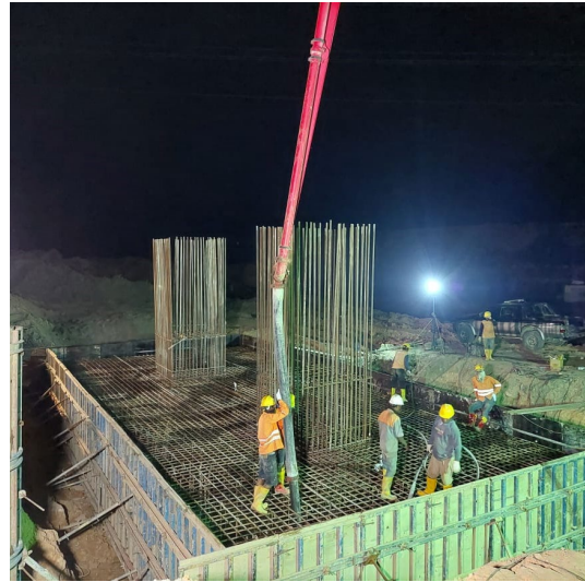
Gambar 7 Proses Pengecoran Pile Cap Jembatan Sungai Wain
