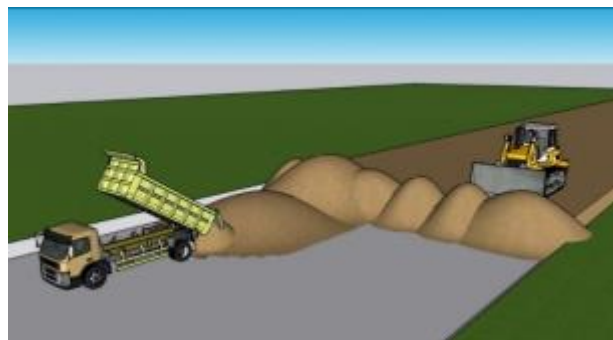
Gambar Pekerjaan timbunan biasa
