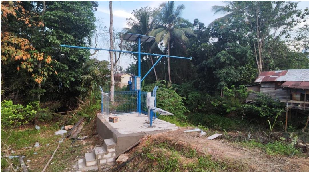
Gambar 8. Proses Pemasangan Pondasi, Tiang untuk Tenaga Panel Surya, Box Panel,udukan alat Curah Hujan Otomatis dan juga manual, dudukan sensor muka air dan Pagar BRC (Kondisi 50%)
