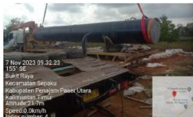
Gambar 5. Proses langsir pipa di gudang
