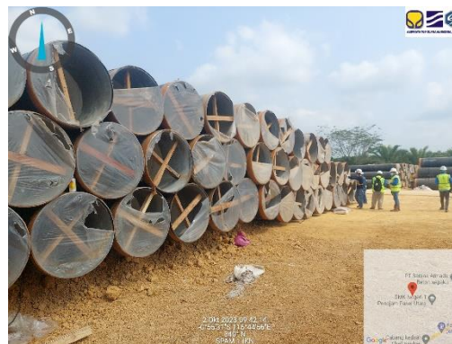
Gambar 4. Tumpukan pipa di gudang
