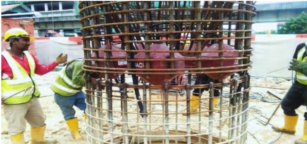
Gambar 6. Intalasi Yjack pada pondasi borepile
