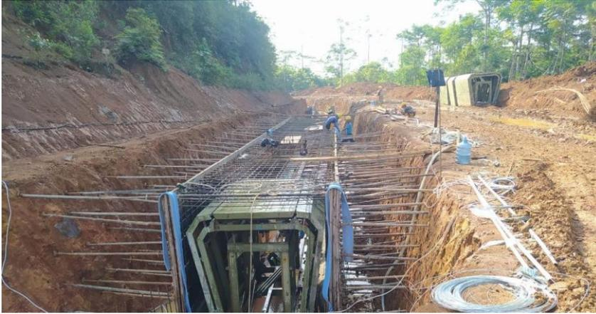
Gambar 1 Pekerjaan irigasi saluran tertutup menggunakan square form work
