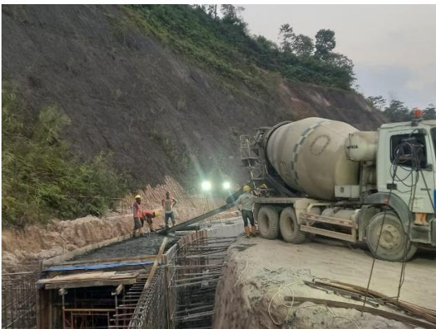
Gambar 2 Pekerjaan irigasi saluran tertutup menggunakan bekisting manual
