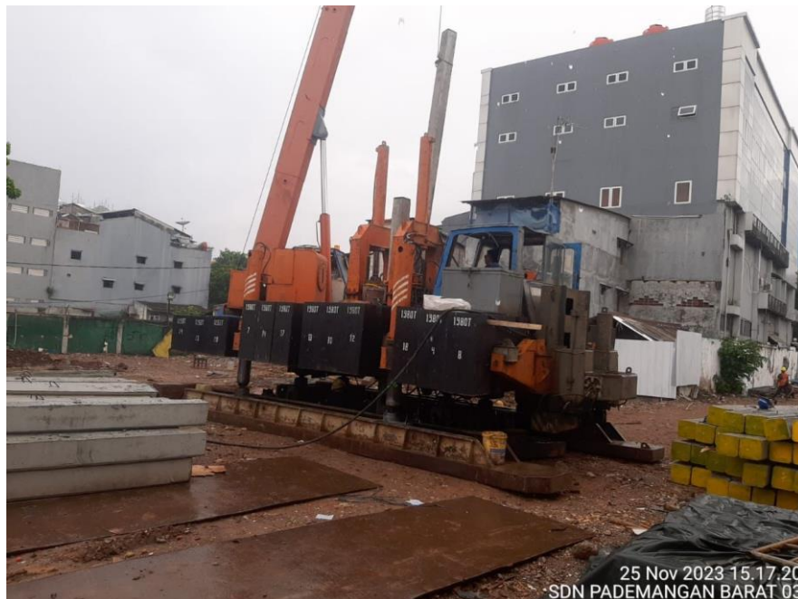
Gambar 1.1 Pekerjaan Pemancangan
