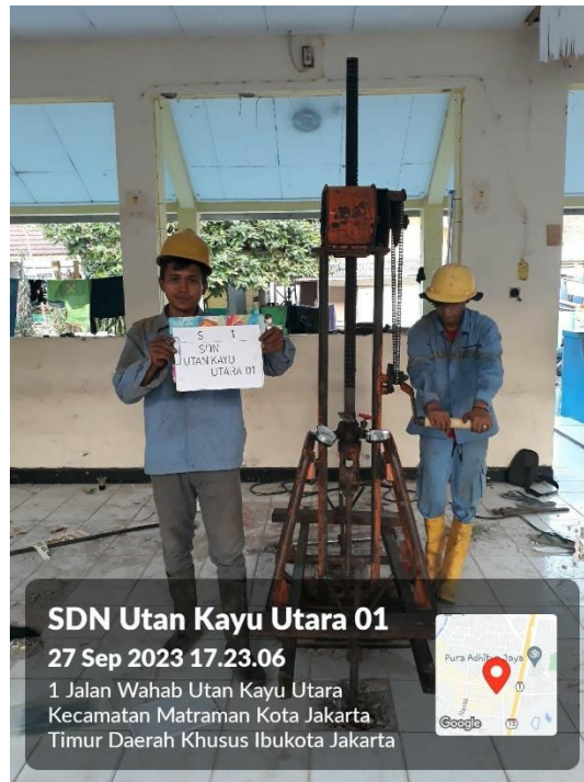
Gambar 1.2 Pelaksanaan Pekerjaan Sondir
