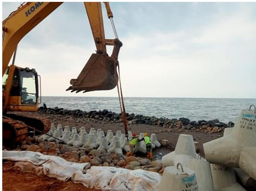
Gambar 5. Ilustrasi Pemasangan Tetrapod
