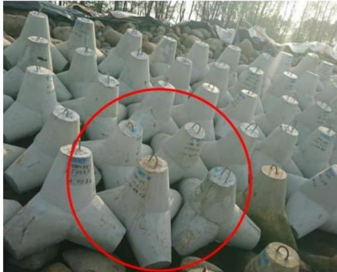
Gambar 7. Penyusunan Tetrapod Layer 1
