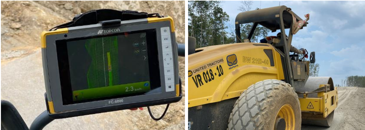
Gambar 15. Dokumentasi saat pekerjaan pemadatan dilakukan.
