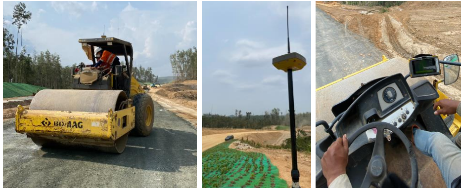
Gambar 11. Site localization dan trial pemadatan dengan intelligent compaction .
