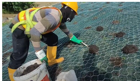
Gambar 1.4 Metode Instalasi Taplok tanaman LCC pada geomat
