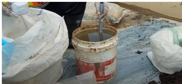
Gambar 1.2 Pencampuran Teraglu, Terboster, Terasorb ke dalam air bersih
