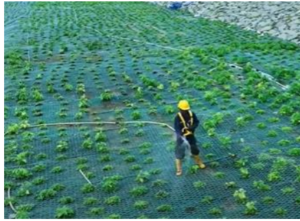
Gambar 1.5 Penyiraman Tumbuhan LCC yang telah terpasang pada geomat
