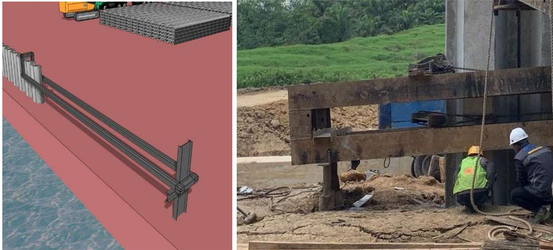
Gambar 10. Pemasangan *Guide Beam*
