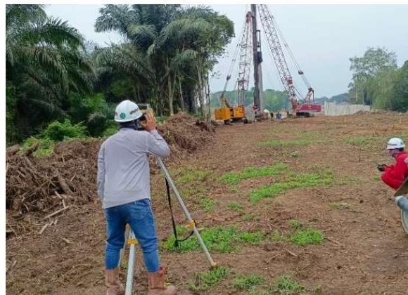
Gambar 15. Pengukuran Kembali Posisi CCSP
