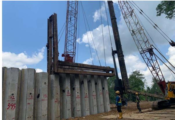
Gambar 14. Pelepasan Guide Beam
