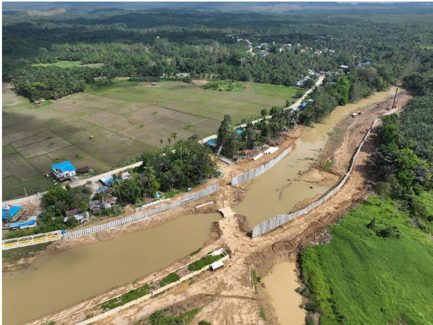
Gambar 17. Hasil Pемancangan CCSP Proyek Penanganan Banjir Sungai Sepaku (IKN)
