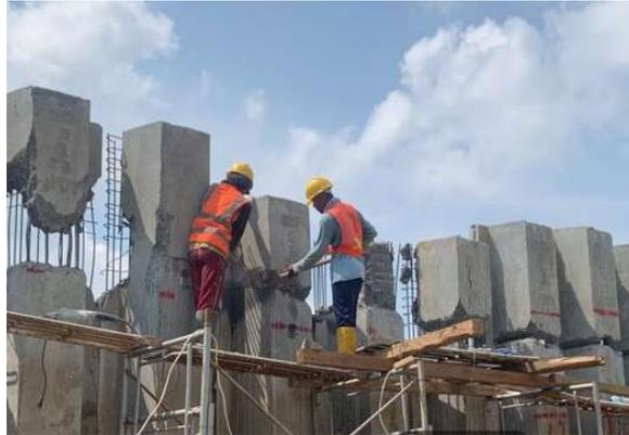
Gambar 16. Pemotongan CCSP
