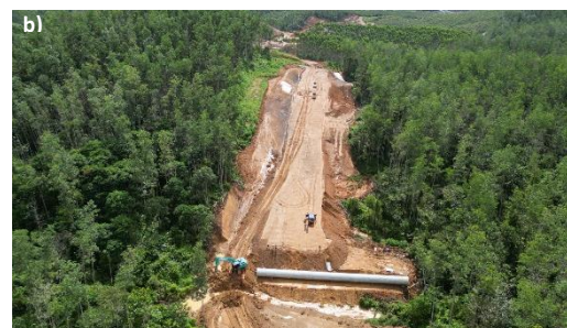
Gambar 4. a) Pemasangan Selimut Pengendali Erosi pada Lereng; b) Instalasi Pipa Baja Bergelombang Armco untuk drainase
