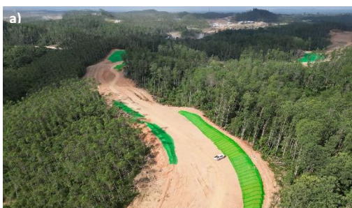
Gambar 4. a) Pemasangan Selimut Pengendali Erosi pada Lereng; b) Instalasi Pipa Baja Bergelombang Armco untuk drainase
