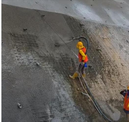
Gambar 2 Pemasangan weephole & penyemprotan shotcrete
