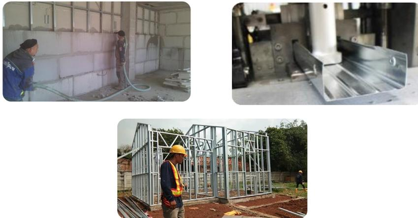
Gambar 1 Pendarapan Infill Wall
